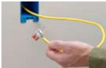
2. Определите схему разводки кабеля. Выровняйте все 4 пары (8 проводников).
